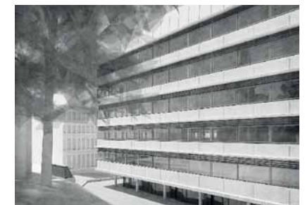
Blick von dem Kapellenhügel auf das Gebäude
