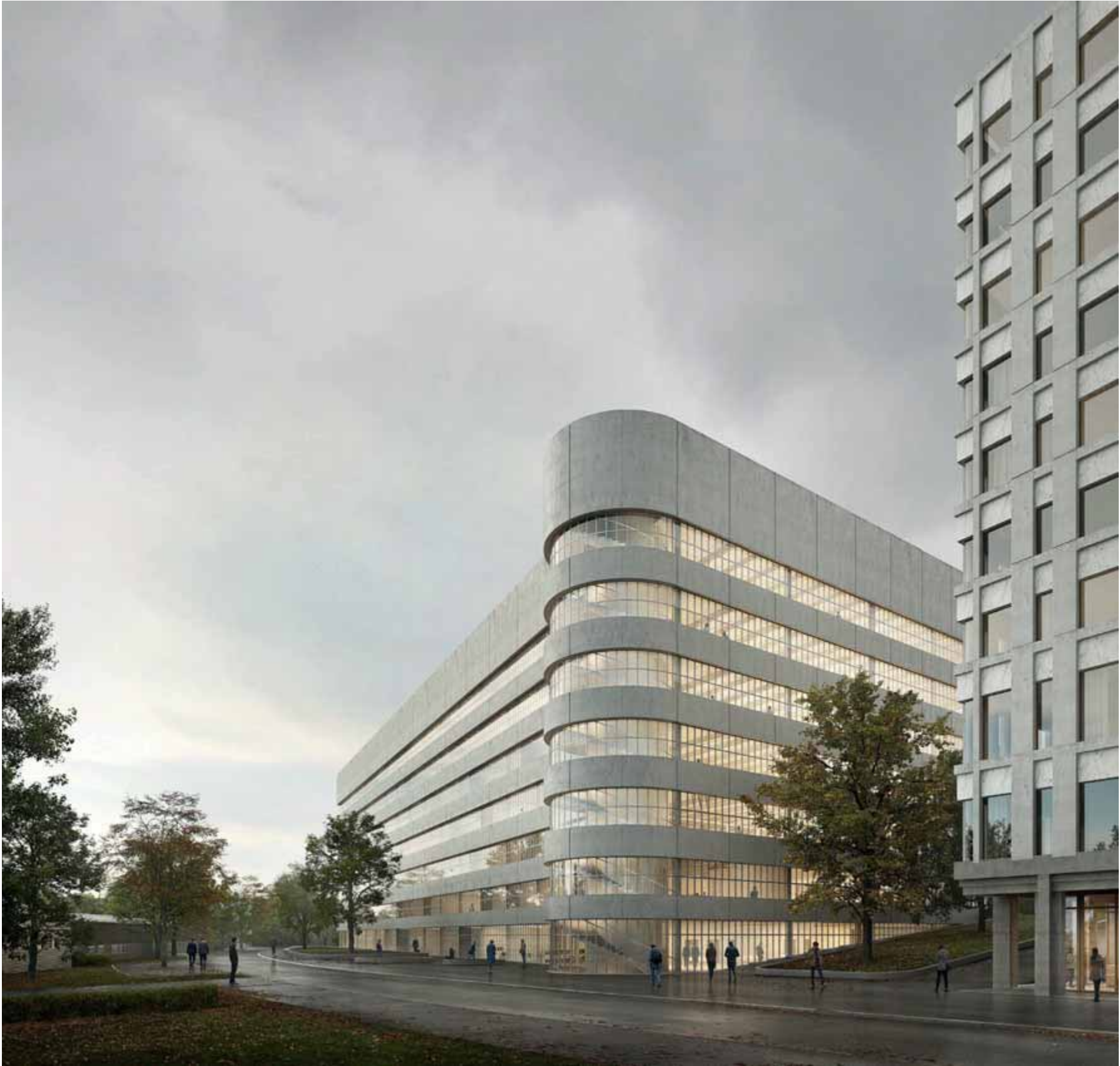
Blick auf den Haupteingangsbereich mit dem prägnanten Haupttreppenhaus
